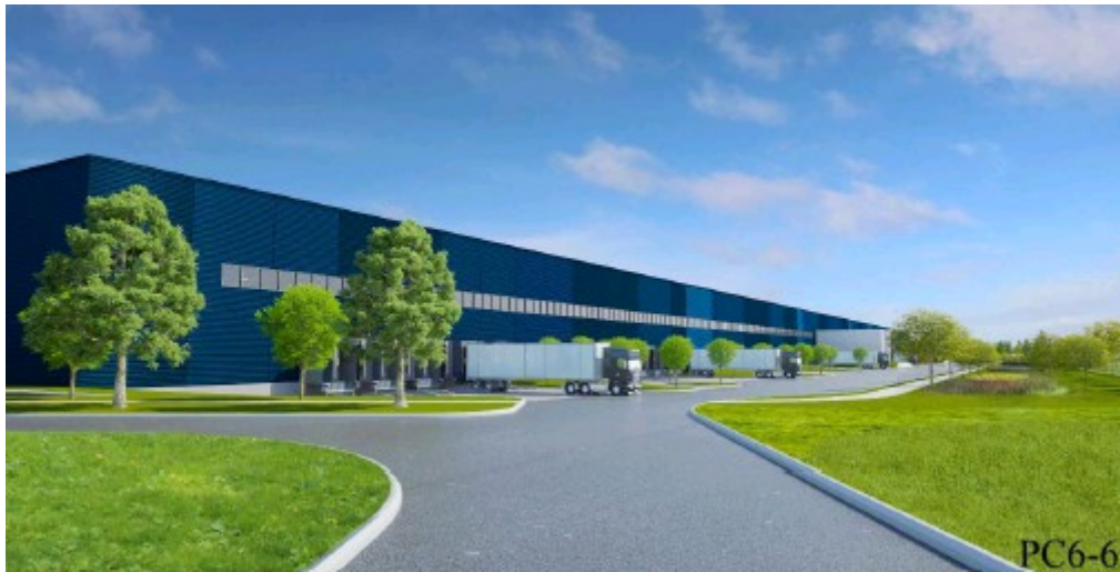
Façade de l'entrepôt
